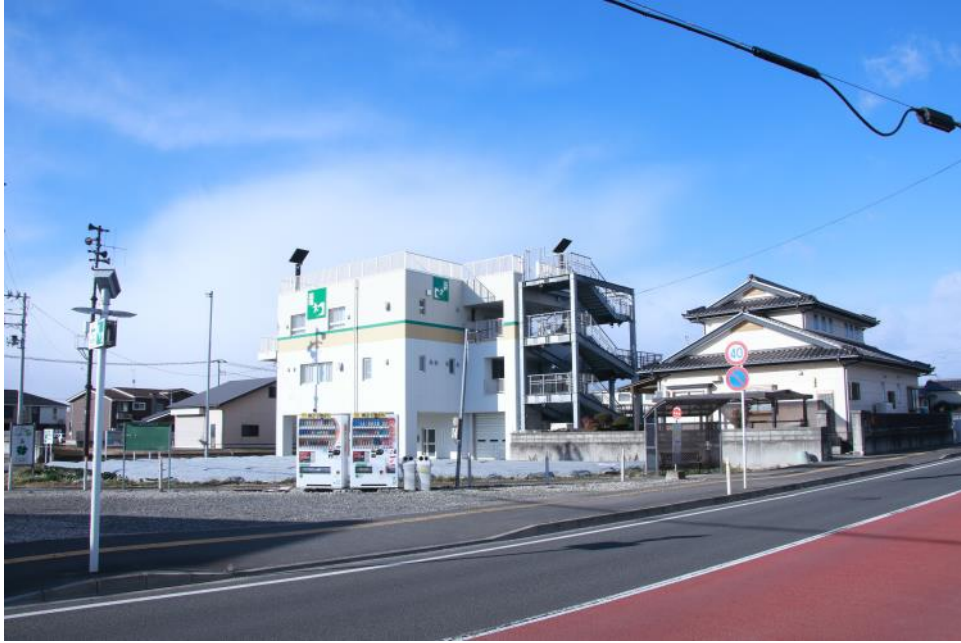
社區內的海嘯避難設施，一樓存放當地消防用的設備
