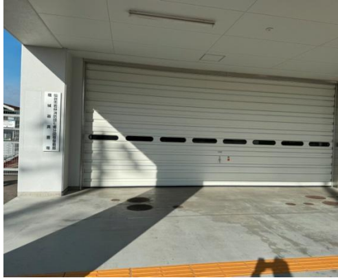
1 樓為重機械放置區
