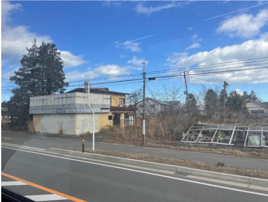
災區街道，右邊為被拆除的房子
